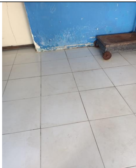
Lantai kedap air dan tidak licin
