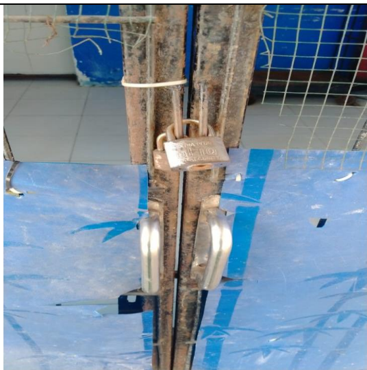
Kunci/gembok TPS B3 yang emndakan selain petugas tidak bisa masuk
