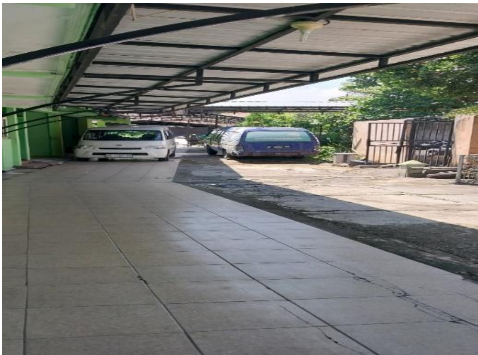
Gb.18 Lokasi berdekatan TPS B3 dan IPAL
