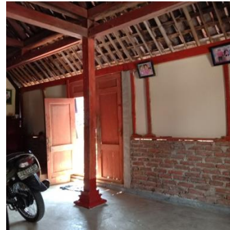
Gambar 2. Kondisi Dalam Rumah
