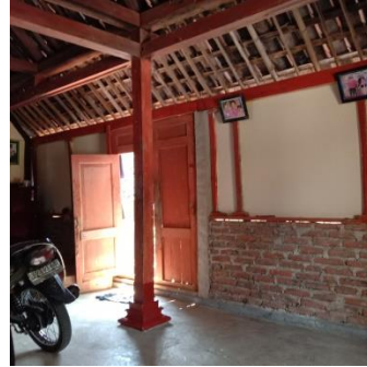
Gambar 2. Kondisi Dalam Rumah
