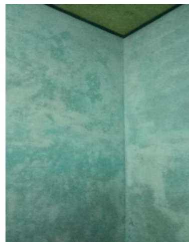
Dinding rumah responden beton
