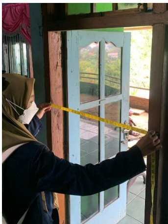
Pengukuran Luas Ventilasi
