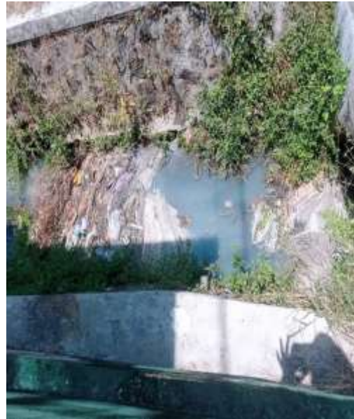
Gambar 2. Keadaan selokan sangat kotor dan muncul bau yang tidak enak
