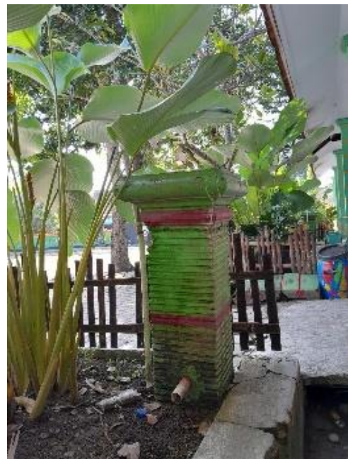
Saluran pembuangan air limbah dan penetasan air hujan Di SDN Mategal 2
