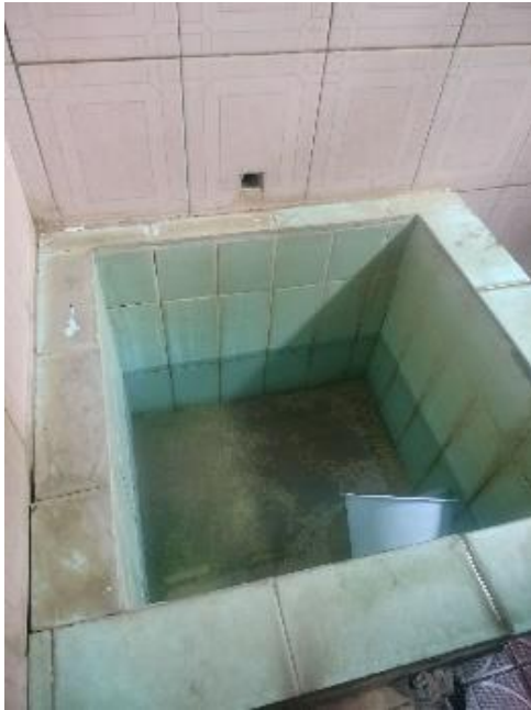
Kondisi bak penampung air di SDN Trosono 2
