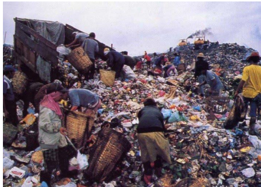
Gambar 2.1 TPA dengan metode Open Dumping (Sumber: Nurul, 2013)
