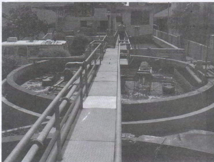
Gambar 4.17. Bak aerasi dengan bentuk bulat.
