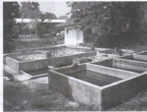
Gambar 3.7.a. Unit Pengolahan Air Limbah Rumah Sakit dengan Sistem Lumpur Aktif Standar.
