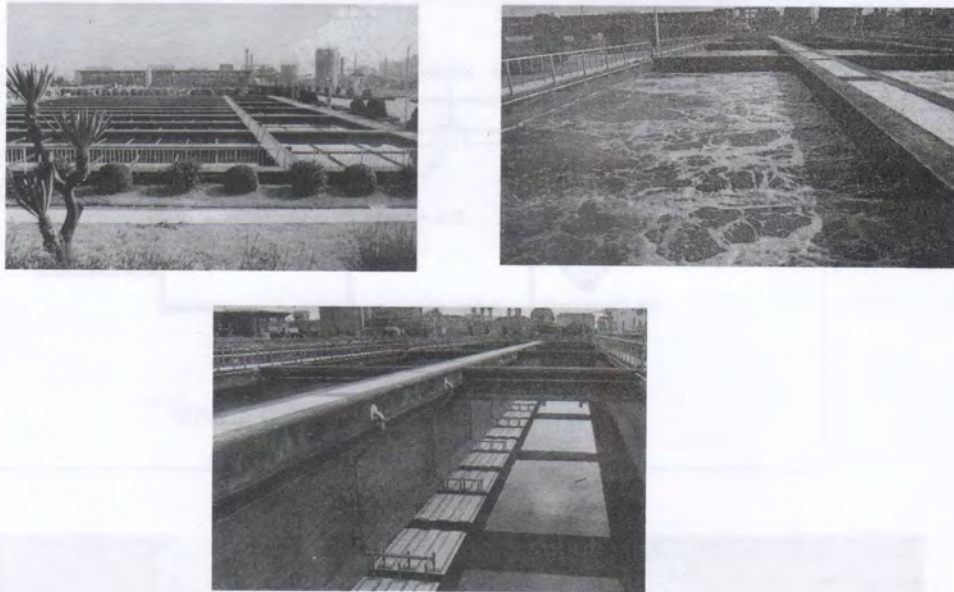
Gambar 3.7.b. Unit Pengolahan Air Limbah dengan Sistem Lumpur Aktif Standar
