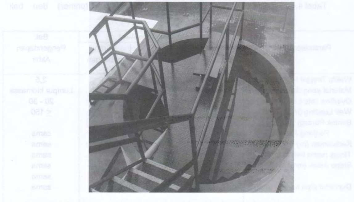
Gambar 4.16. Salah satu contoh bak pengendapan bentuk bulat.
