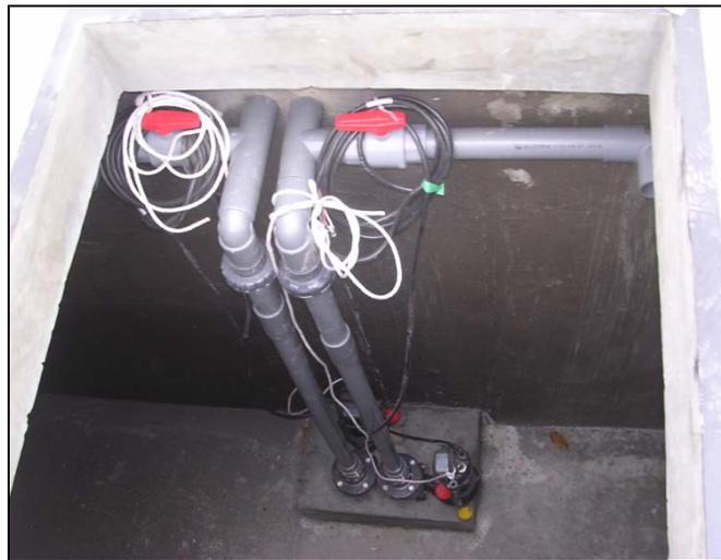
Gambar 3.15 : Contoh Pemasangan Pompa Celup Untuk IPAL.
