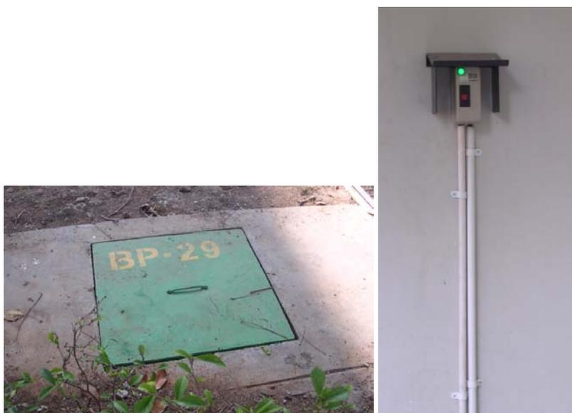
Gambar 3.5 : Bak Pengumpul Air Limbah (Tampak dari Atas) dan Panel Kontrol Pompa.
