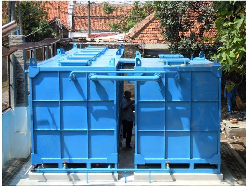
Gambar 3.24 : IPAL Biofilter Anaerob-Aerob Yang Dibuat Dari Bahan Plat Baja Yang Dilapisi Dengan Bahan Anti Karat.
