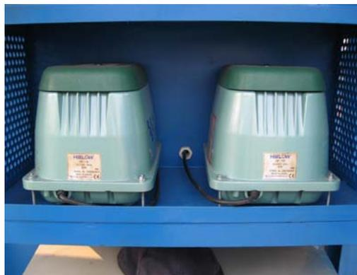
Gambar 3.31 : Blower Udara Tipe HIBLOW.
