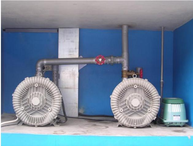
Unit Pemasok Udara Yang Terdiri Dari Ring Blower Dan Blower Tipe Hiblow.
