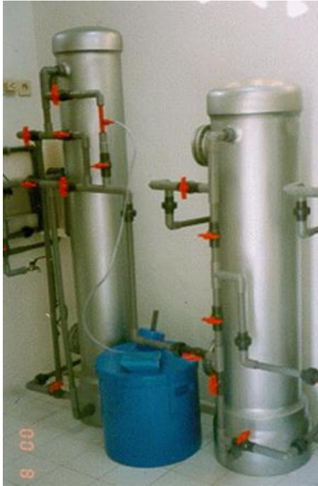
Gambar 6 : Filter Multi Media, Tangki Larutan Garam Dan Filter Penukar Ion Yang Telah Terpasang.
