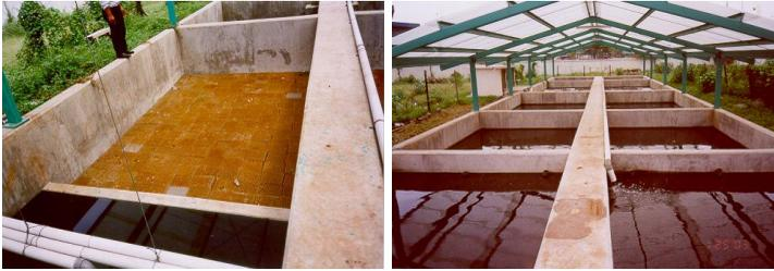
Gambar 3.22 : Reaktor Biofilter Anaerob Dari Bahan Beton Bertulang.
