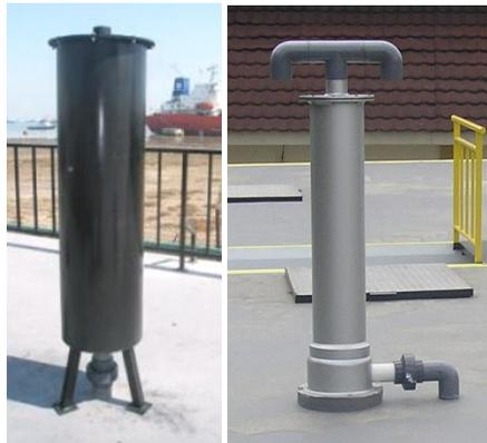
Gambar 3.23 : Contoh Filter Penghilang Abu Yang Dipasang Di Pipa Pembuangan Gas Reaktor Biofilter Anaerob.
