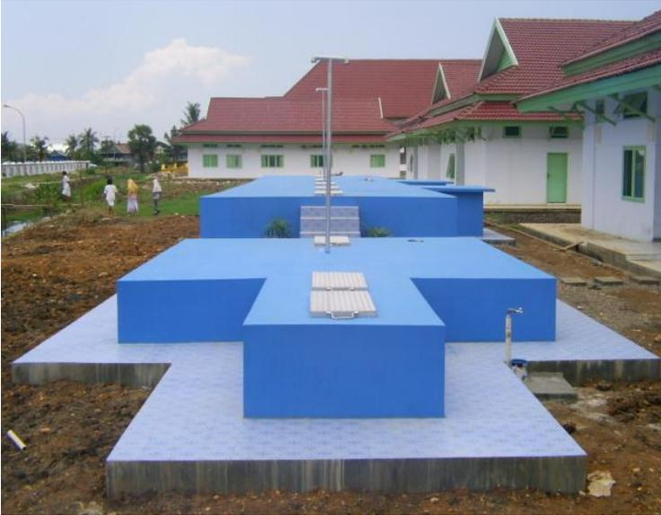
Gambar 3.25 : IPAL Biofilter Anaerob-Aerob Bentuk Dari Bahan Beton Bertulang.
