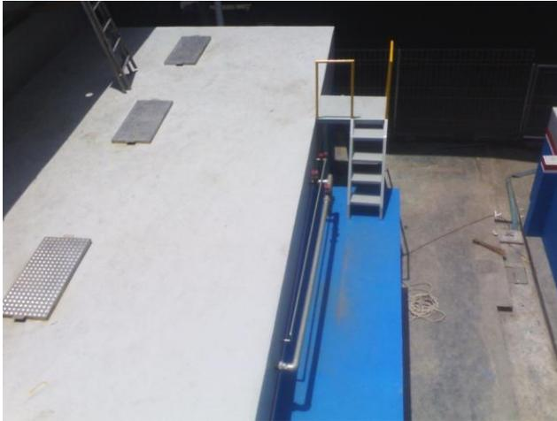
IPAL Biofilter Anaerob-Aerob Yang Terdiri Dari Bak Pengedap Awal, Biofilter Anaerob, Biofilter Aerob Dan Bak Pengedap Akhir.
