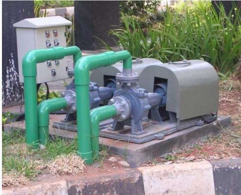
Gambar 3.17 : Contoh Pemasangan Pompa Centrifugal Untuk IPAL.
