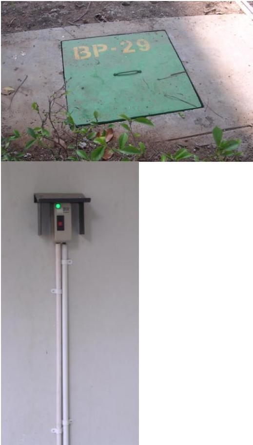
Gambar 3.5 : Bak Pengumpul Air Limbah (Tampak dari Atas) dan Panel Kontrol Pompa.
