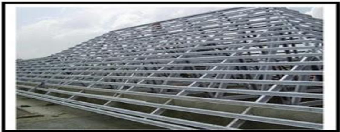
Gambar : Rangka Atap Baja Ringan
