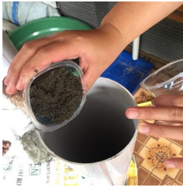
Gambar 15. Media filtrasi di masukkan dalam bak filtrasi dengan kedalaman 60 cm
