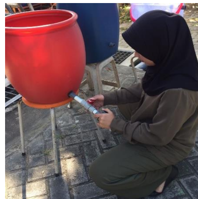
Gambar 4. Pemasangan kran pada bak aerasi
