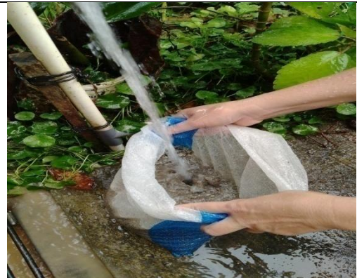
Gambar 8. Pencucian Pasir dan Kerikil
