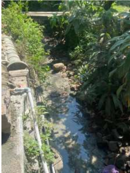
Saluran pembuangan limbah langsung ke badan air
