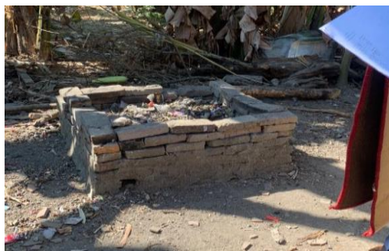
Tempat sampah tidak memenuhi syarat karena tidak terdapat penutup
