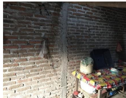
Kondisi dinding yang memenuhi syarat
