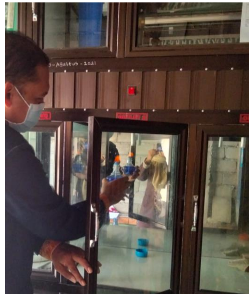
Flambir pada pipa keluarnya air DAM
