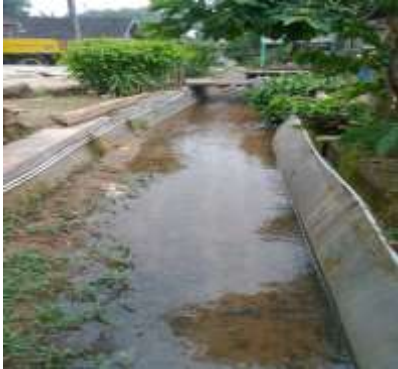
Kondisi Sungai Dusun Prataan
