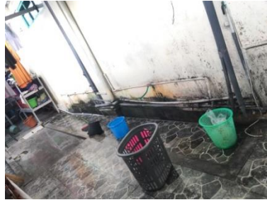
Gambar 1. Kondisi Sekitar Depot Air Minum
