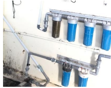
Gambar 8. Mikrofilter yang harus diganti
