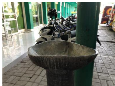
Gambar 3 Tempat Cuci Tangan Tidak Tersedia Sabun
