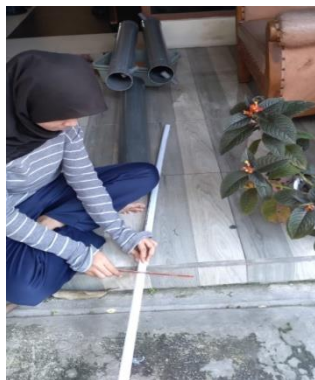
Gambar 5 Proses Pemotongan Pipa Pvc
