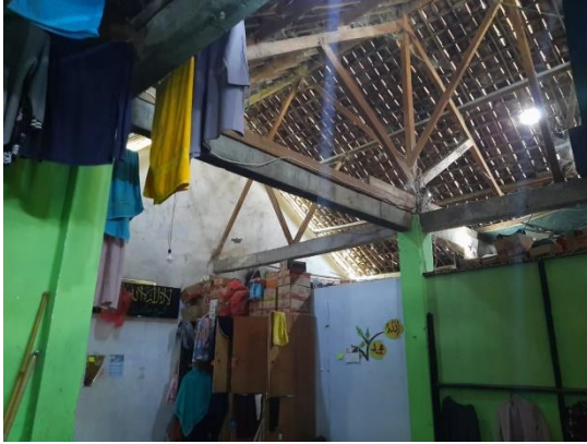
Kondisi Langit-langit / Atap Kamar
