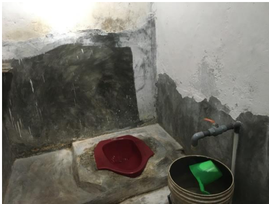
Kondisi jamban responden
