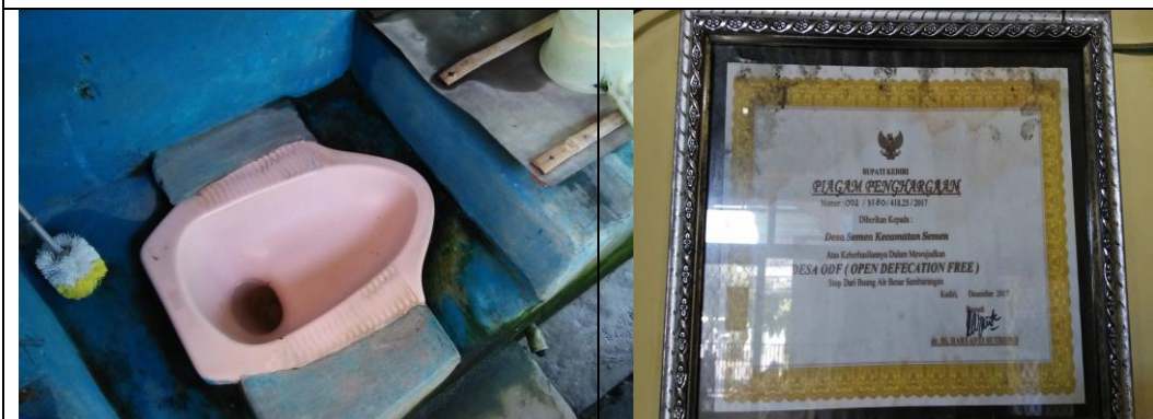
Pemeliharaan jamban yang kurang bersih
