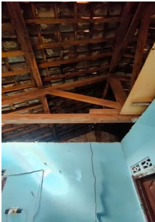
Dokumentasi Kondisi Fisik Rumah Bagian Atap Rumah
