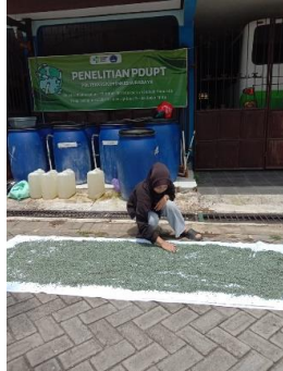
Gambar 7. Pengeringan batu zeolit (sebagai media adsorpsi) yang telah dicuci
