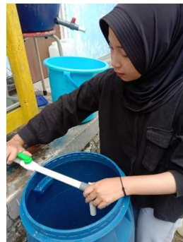
Gambar 4. Pemasangan kran pada bak aerasi ke bak adsorpsi
