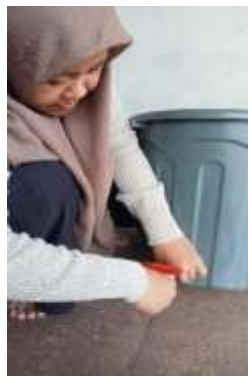
Pemasangan kran pada bak aerasi
